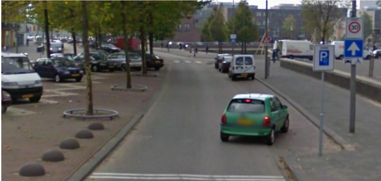
Figuur 4.2 – ETW ingericht met aparte rijbanen (en wordt gebruikt als doorgaande verbinding)
